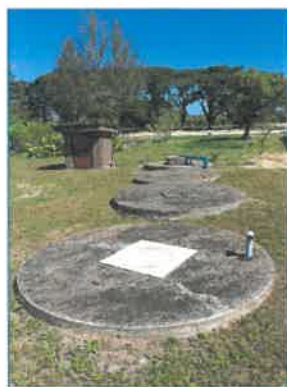
บ่อดักตะกอนจำนวน 3 บ่อและบ่อดักน้ำใส
