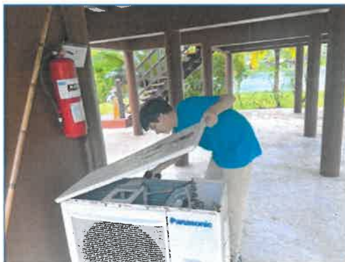
ภาพถ่ายที่ 2.2-20 การทำความสะอาดเครื่องปรับอากาศ
