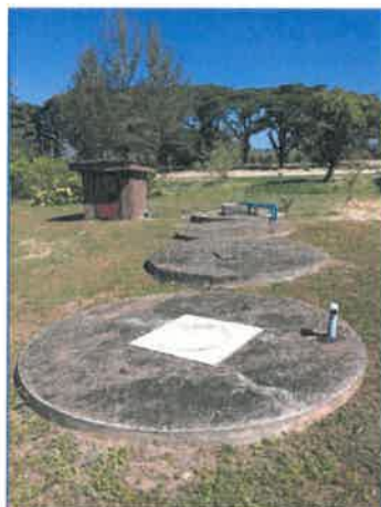
ภาพถ่ายที่ 2.2-9 ระบบบำบัดรวมและบ่อพักน้ำทิ้งสุดท้าย
